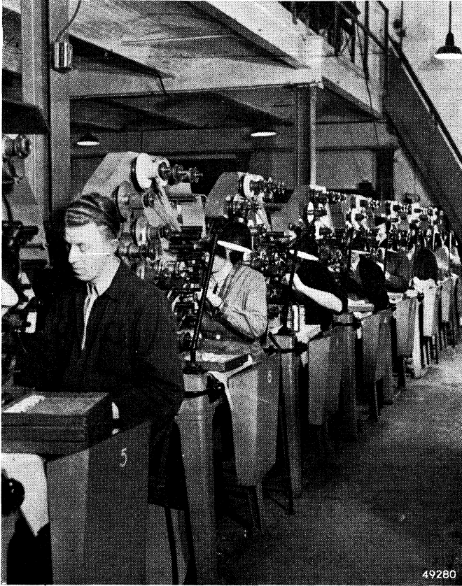
Fig. 226 Serie wikkelmachines voor papiercondensatoren.
